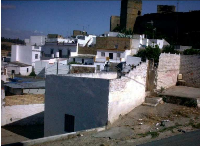
Vista de la edificación en ruina existente. Esquina C/ Trovador con Avda del Águila.
