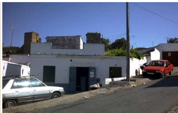
Vista de la edificación existente en C/ Fuentes esquina Avenida del Águila.
