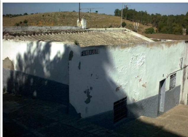
Vista de la edificación existente. Esquina Calle Fortaleza nº1 con Avenida del Águila.
