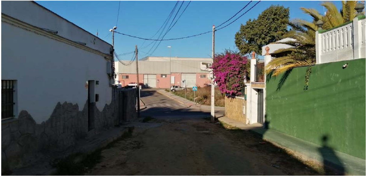
Fotografía 4. Vista detalle C/ Luxemburgo
